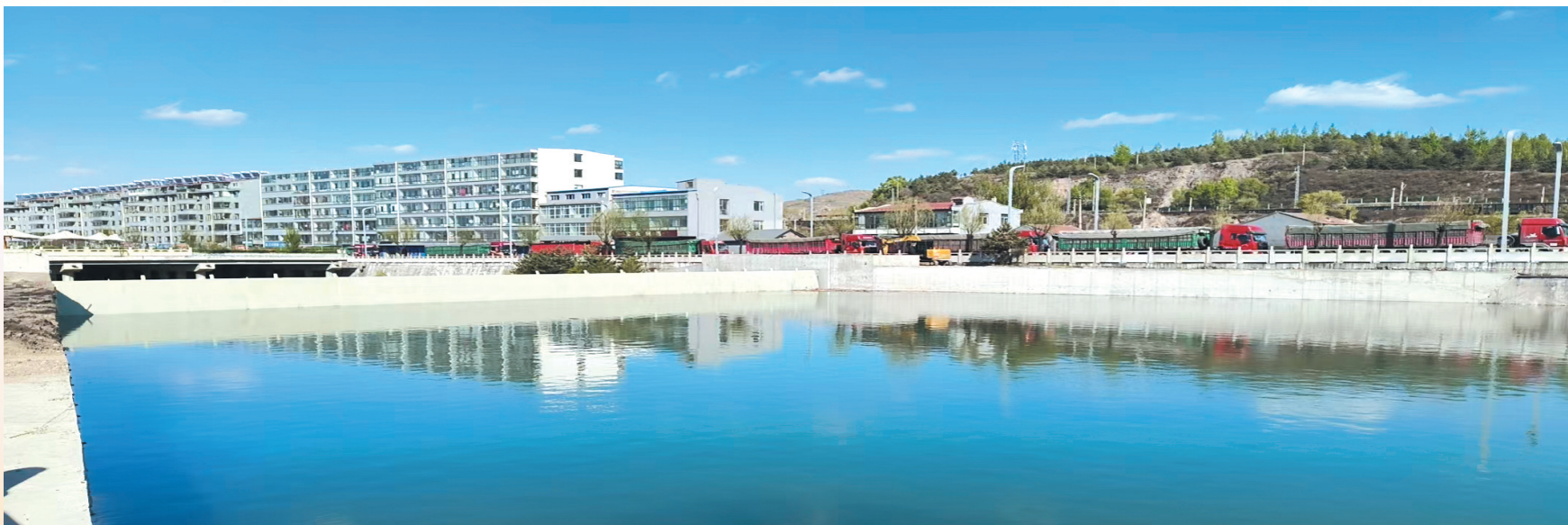
恢河水上游公园蓄水坝内碧波荡漾
