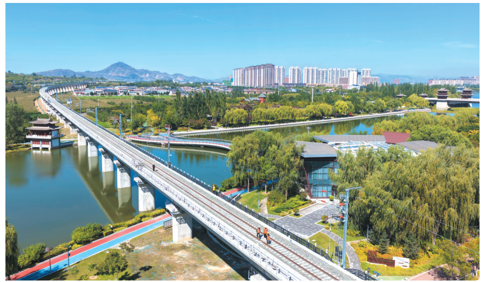
10月11日,在雄忻高铁忻府区段,建设者正在对轨道开展巡检。 本报记者 张存良摄
