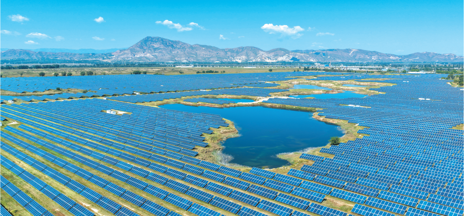
村振兴。大力发展光伏发电产业，充分挖掘光照资源，赋能绿色转型，助力乡村振兴。九月二十二日，忻府区永丰庄村，连片光伏板整齐排列。当地
