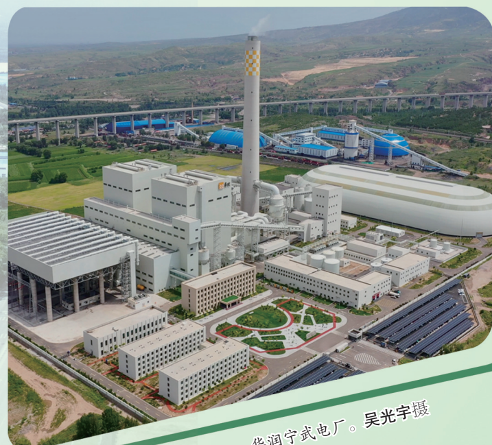
华电中泉忻府区30万千瓦光伏项目全容量并网发电 张存良摄
