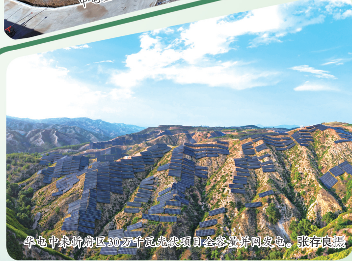
中电金谷偏关混合储能独立调频电站 冯晓磊摄
