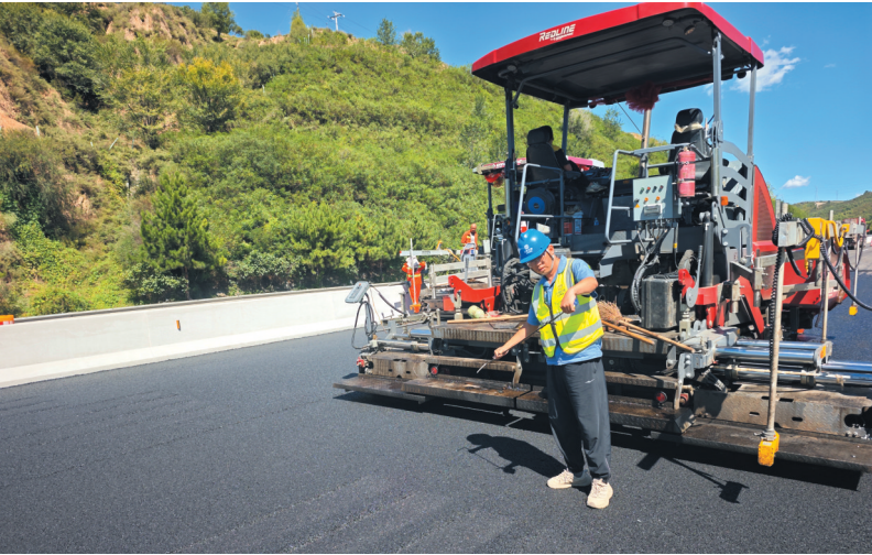
监理工作人员现场检测沥青路面摊铺层厚度
