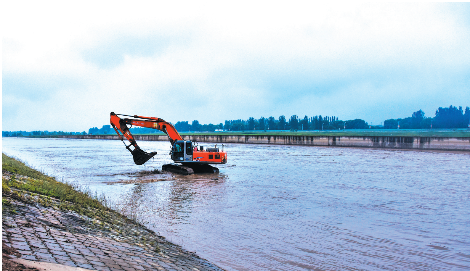
8月29日，原平市滹沱河清淤疏浚施工现场，工作人员驾驶大型挖掘机开展涉水作业，对河道淤积泥沙进行清理疏浚，拓宽行洪通道，提升河道排涝行洪能力，消除汛期安全隐患，切实守护沿岸群众生命财产安全。 吉建平摄
