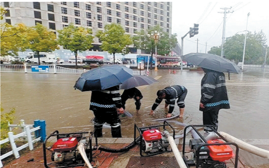
抢险人员对城区积水路段进行抽排
