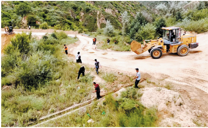
抢修作业现场。
