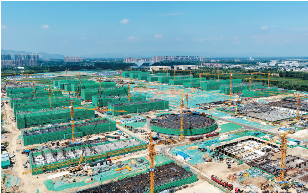
7月25日，在太原科技大学忻州校区项目建设现场，吊车林立，机器轰鸣，工程车辆往来穿梭，施工人员各司其职，一派热火朝天的繁忙景象。 本报记者 冯晓磊摄
