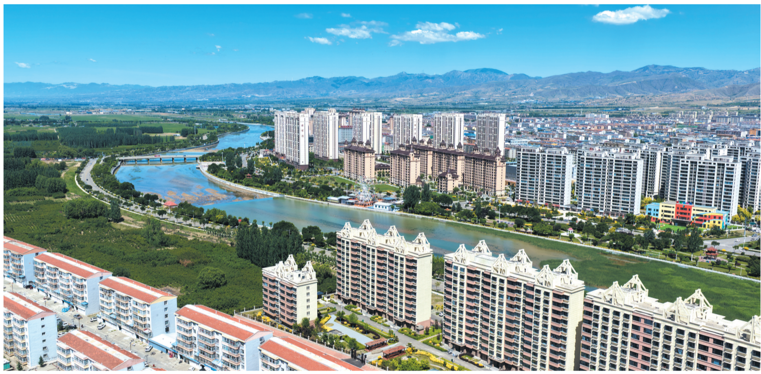
航拍视角下的繁峙县城,滹沱河支流穿城而过,两岸高楼林立,草木葱郁。近年来,该县持续推进城市基础设施升级与生态环境治理,城市颜值与民生温度同步提升,绘就了一幅“城在绿中、人在景中”的宜居画卷。本报记者 张存良摄
