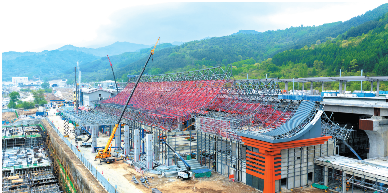
月二十七日,施工现场机械轰鸣,工人忙碌有序。本报记者 张存良摄
