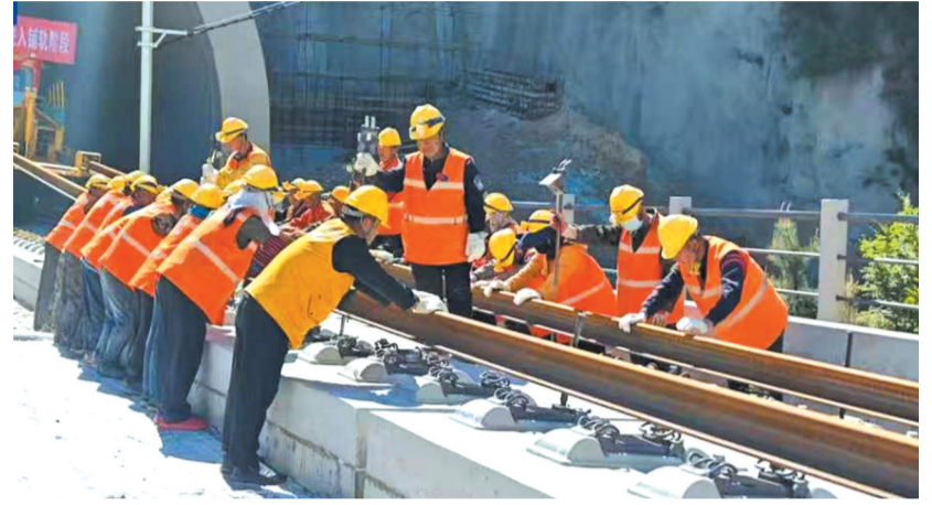
五台县北太行山隧道施工现场。
