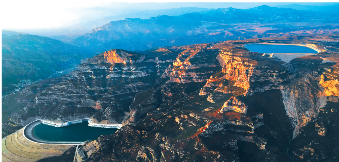
五台县西龙池抽水蓄能电站。 本报记者 宫爱文摄
