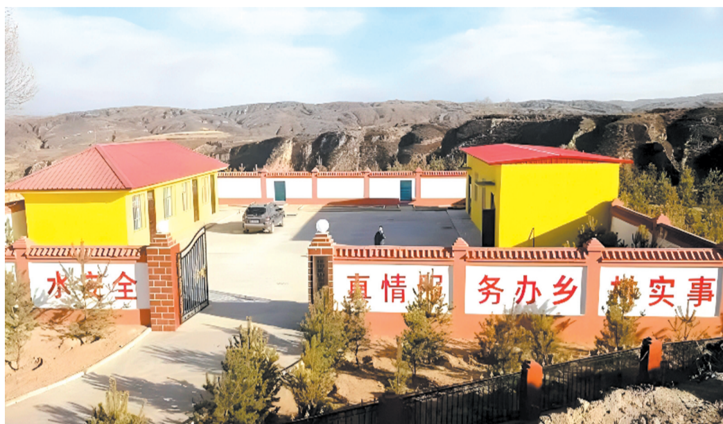
山头梁集中供水工程。
