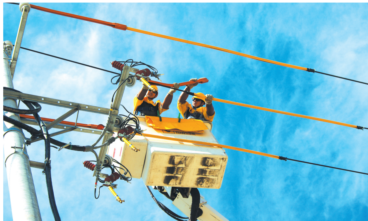
春季是电网设备隐患排查治理、保障全年电网安全稳定运行、护航民生用电的关键节点。为全面提升电网设备健康水平,切实保障辖区居民生活、春耕春灌及企业生产用电需求,国网五台县供电公司紧扣春季电网运行特点,以精细化检修、常态化管控、暖心化服务,采取少停电或不停电作业方式扎实推进春检工作。图为公司员工在10千伏新城II线西龙泉支线带电处理设备缺陷、消除安全隐患。孙立新摄
