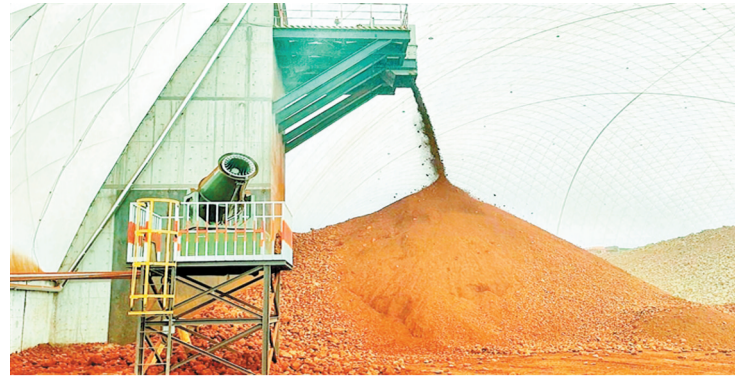
4月15日,4号气膜仓内正在进行自动化矿石倒运作业,同步开启雾炮机降尘。 高舒军摄
