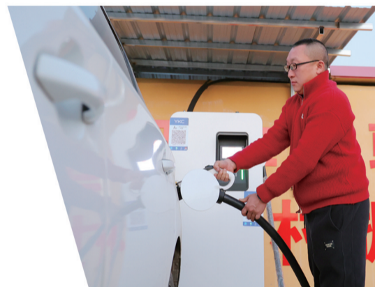
大辐车梁村新能源汽车充电桩
