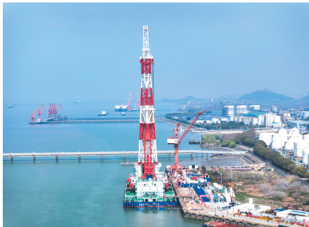
3月31日在江苏南通拍摄的156米动力定位打桩船“铁建大桥桩1”号。
