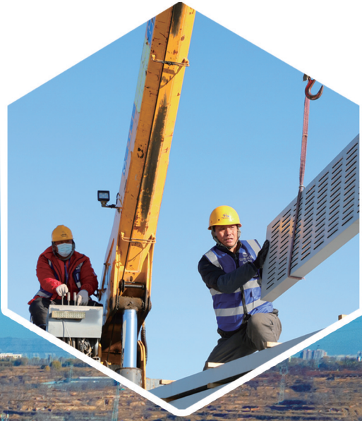
工人正在操作起重设备进行隔音屏的吊装与安装作业
