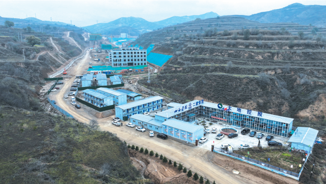
项目施工现场。
