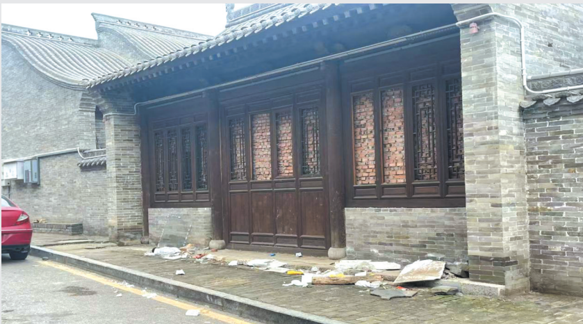
顺城街以南、忻府区乡村e镇公共服务中心对面垃圾堆积
