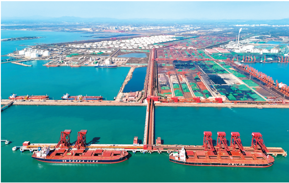
10月27日在山东青岛拍摄的山东港口青岛港第二座40万吨矿石码头。
