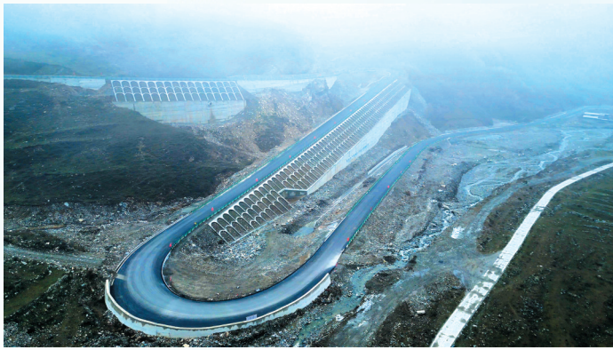
建设中的五台山东线旅游公路。 本报记者 陈勇升摄
