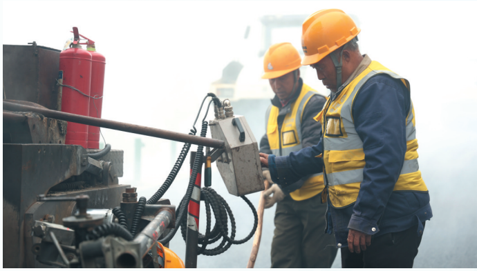
东线项目建设现场,工人专注操作设备。 本报记者 陈勇升摄
