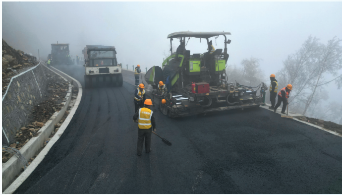
东线项目建设现场,工人在铺设沥青。 本报记者 陈勇升摄
