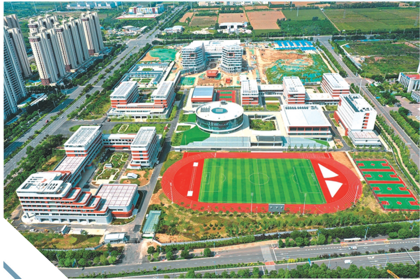
忻州现代康养职业学院完成施工,进入竣工公示阶段。
