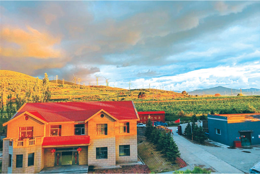
山西国际能源集团云光公司忻州神池霸业梁风电场150MW技改扩容项目。
