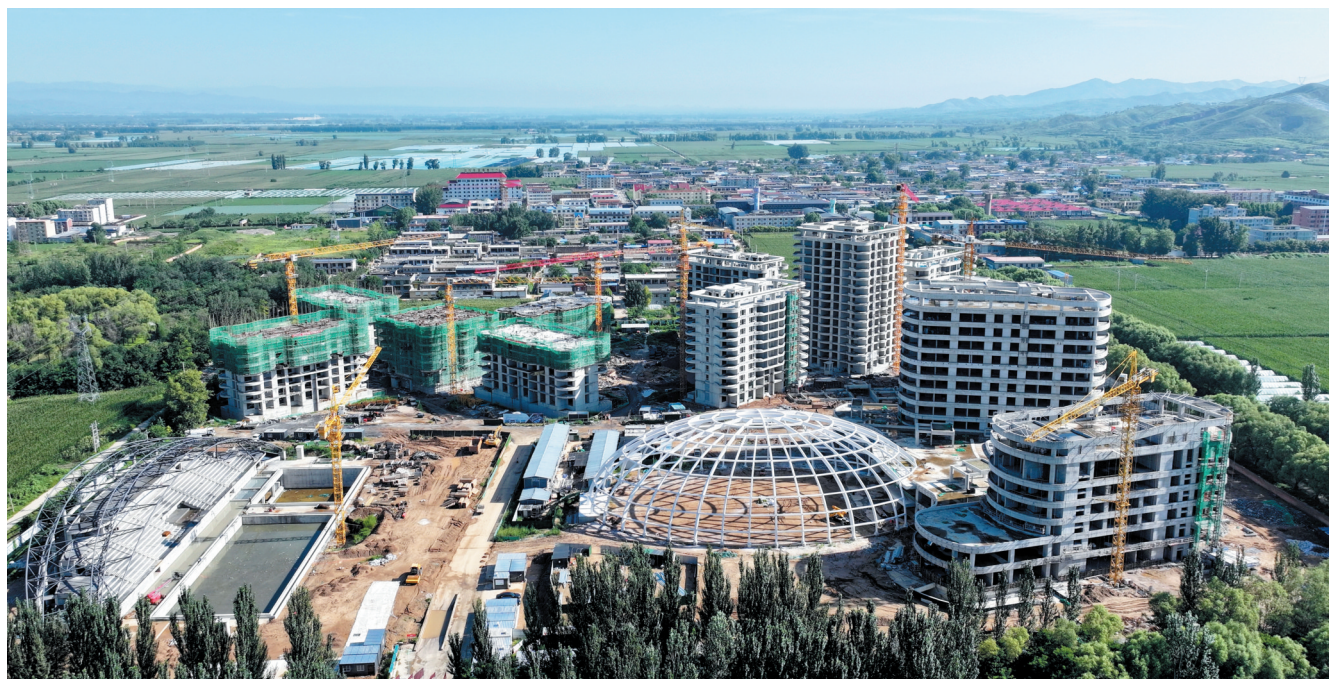
忻府区奇村镇忻州奇泉度假康养项目施工现场,工程建设者正抢抓工期,加速推进项目建设。 本报记者 张存良摄
