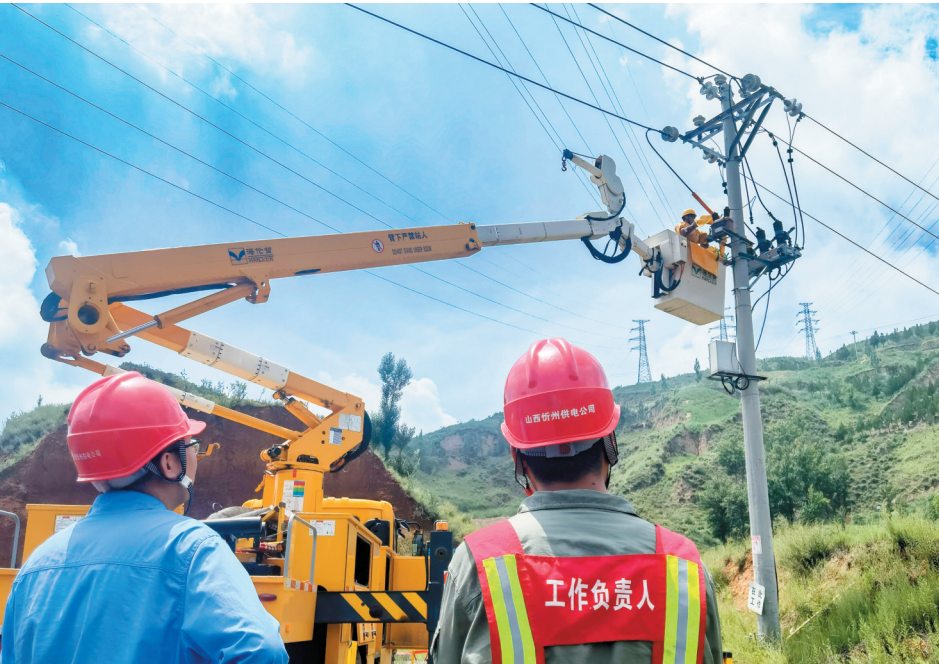
迎峰度夏期间,国网保德县供电公司员工对10千伏882部家里线碳咯沟支线智能断路器的设备线夹进行更换,以应对高温可能引发的大负荷情况。张江鑫摄
