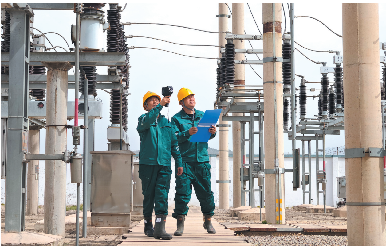
近日,五台县迎来连绵不断的强降雨天气。为确保电网安全稳定运行,保障人民群众的正常用电需求,国网五台县供电公司组织一线班组、供电所工作人员迅速行动,细致开展雨后特巡工作,全面排查电力设施隐患,筑牢供电安全防线。图为7月28日,该公司运维人员对变电站、供电线路和配变台区进行雨后特巡检测。
