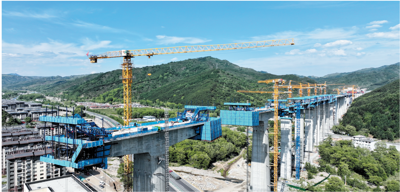
6月21日,雄忻高铁五台山段建设正酣,建设单位抢工期、赶进度,确保项目有序推进。图为雄忻高铁五台山段施工现场。
