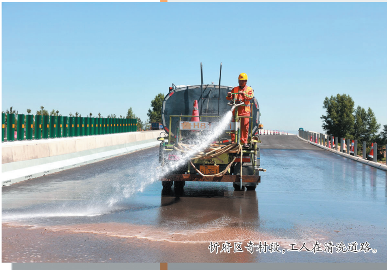
忻府区奇村段道路配套设施安装现场。
