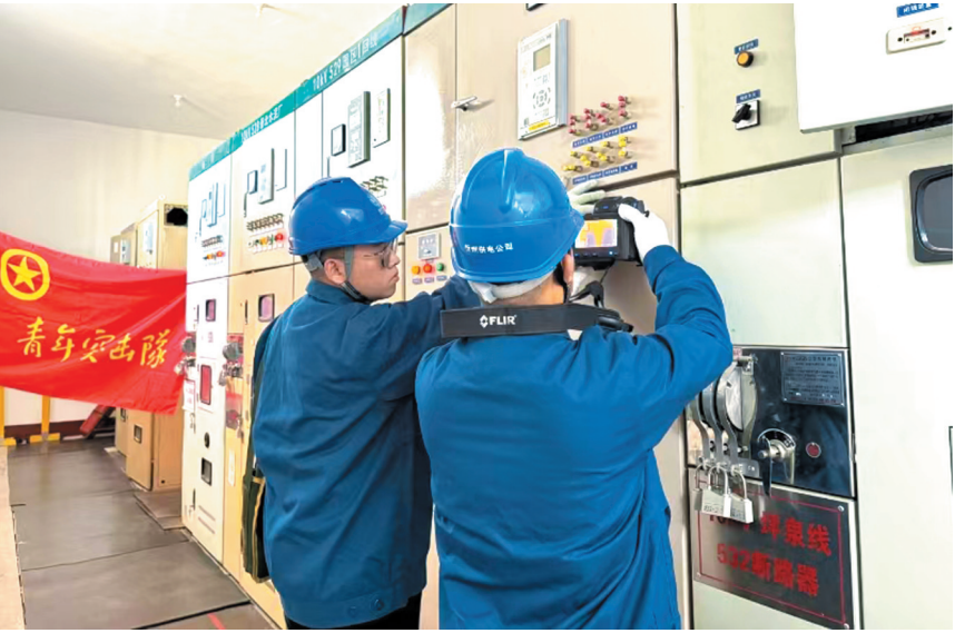
公司青年骨干利用红外测温仪对电力设备监测
